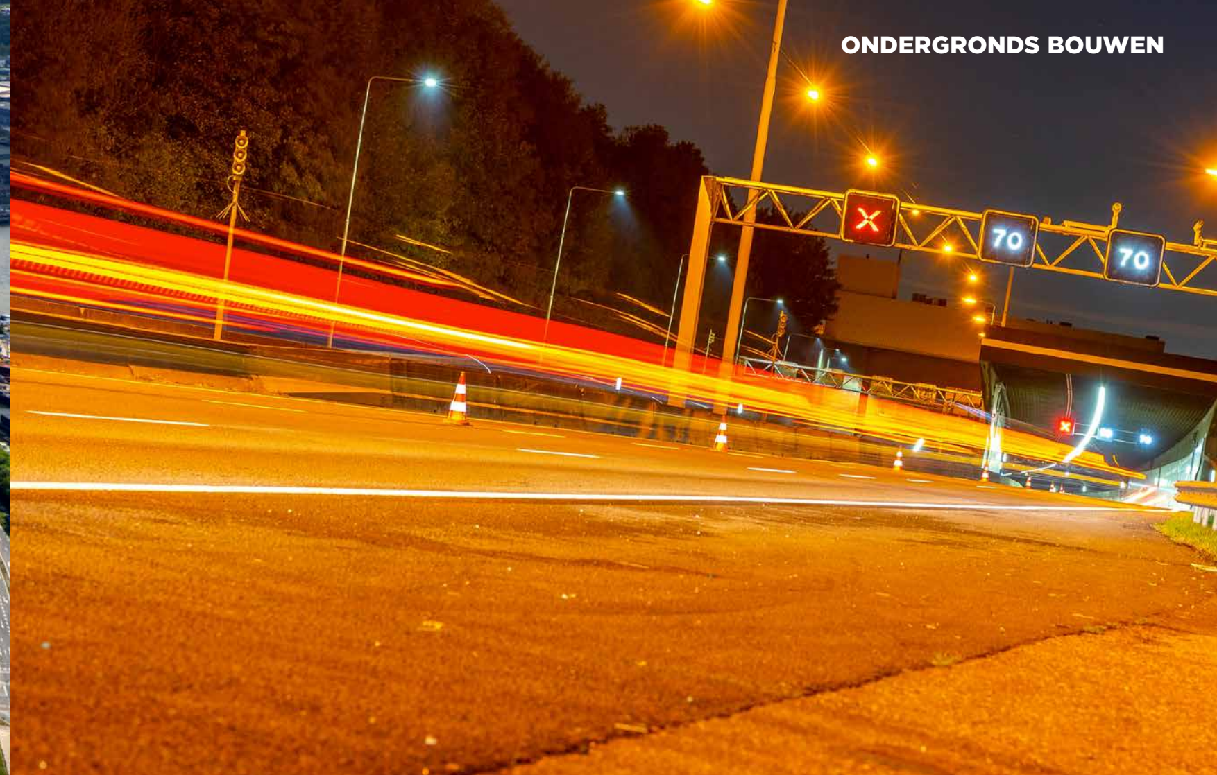
Binnen het Project Tunnelrenovaties Zuid-Holland (PTZ) kiest Rijkswaterstaat bewust voor een portfolioaanpak; een gebundelde aanpak waarin tot 2032 vijf tunnelrenovaties worden uitgevoerd.
