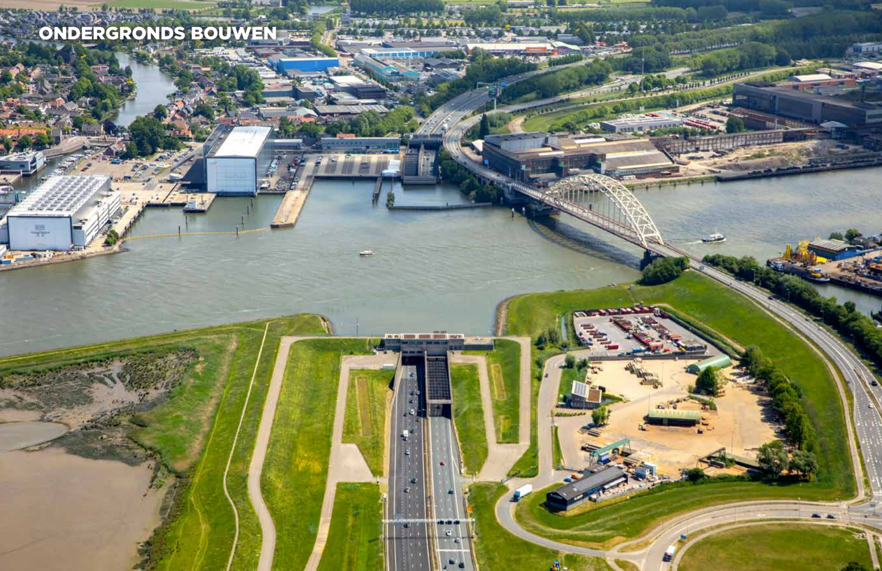
Bij PTZ brengen ze de vijf tunnels op het niveau van de Landelijke Tunnelstandaard, waaronder ook de Noordtunnel in de A15.
